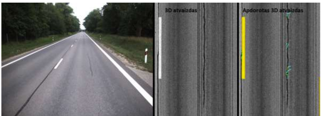
5 pav. Užtaisyto plyšio kelyje pavyzdys
